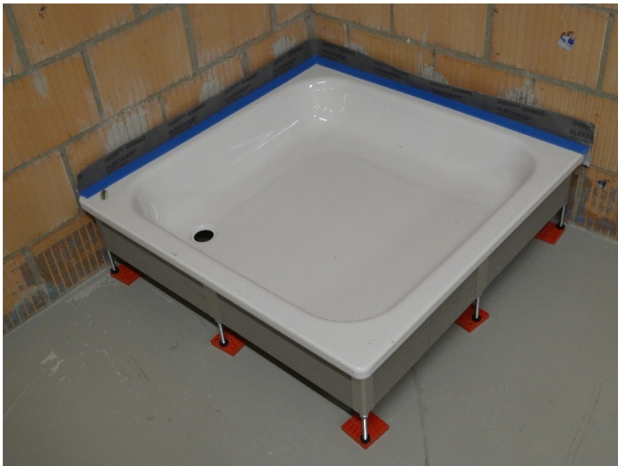
Abbildung 6: Gesamtansicht von Prüfaufbau 2 (Aufbau Nr. 2 vom 02.12.2020)
